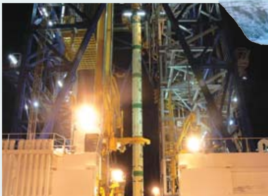
ライザーパイプ(中央)を海中へ降下する様子。「ちきゅう」は、すでに試験航海で海底下3000mを超えるのライザー掘削に成功している。
