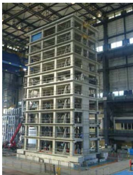
図 - 5 高さ 27.45m 10 層 RC 造建物
