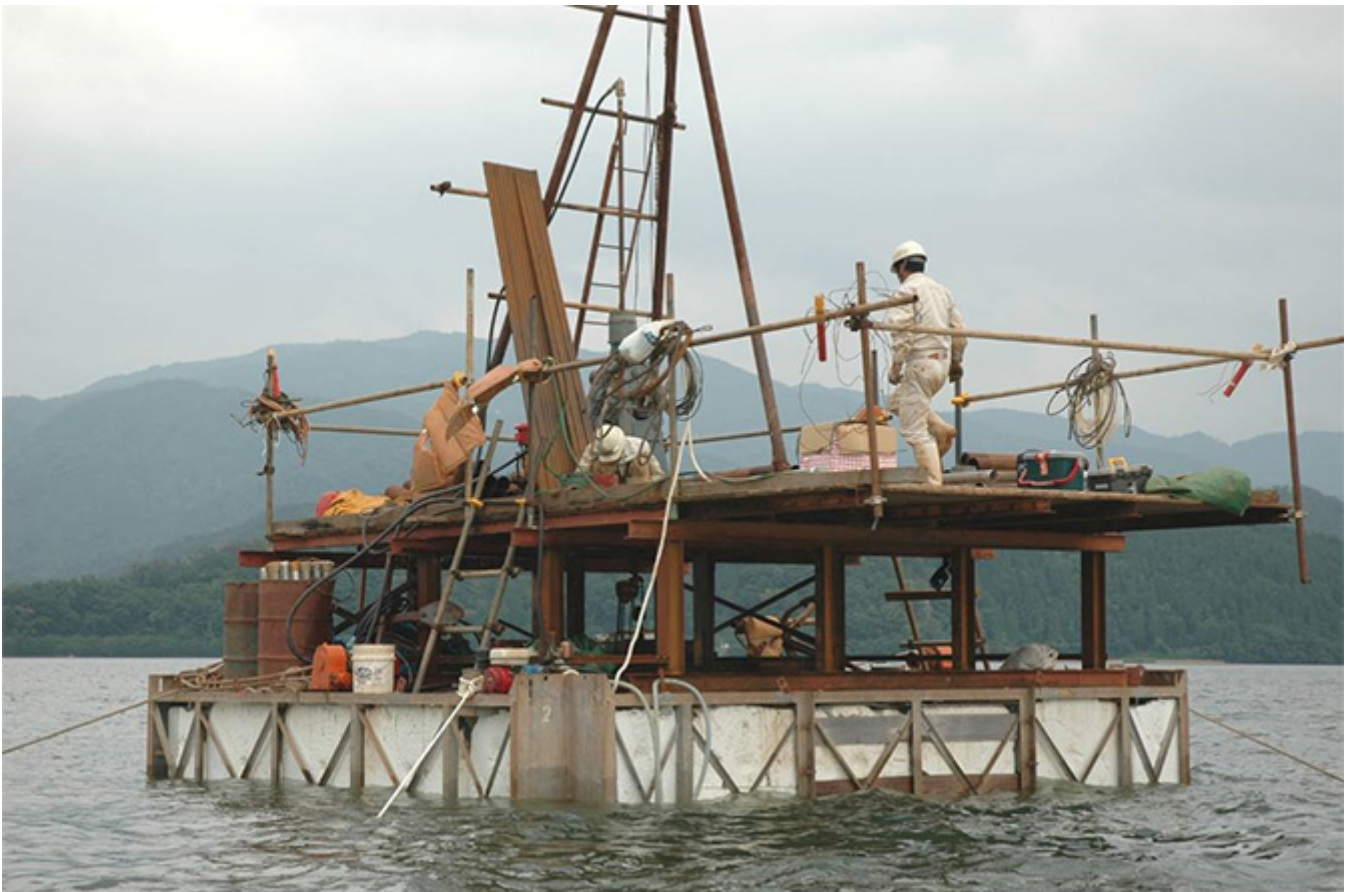
図2 水月湖の掘削作業場
