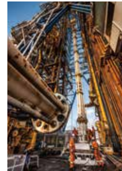
ドリルフロアでのパイプ組み立て作業
