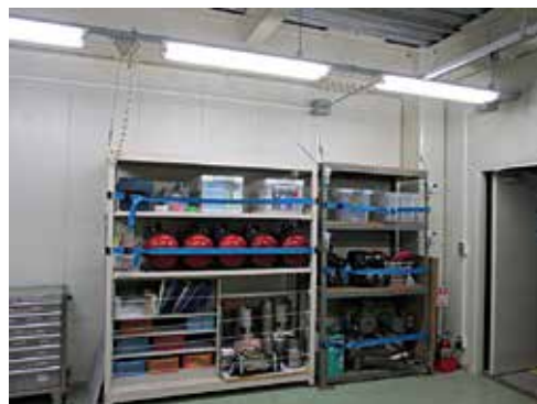
対策後：ワイヤーで棚を固定し、重量物を下段に移すとともに固定ベルトで落下防止策を講じた。
