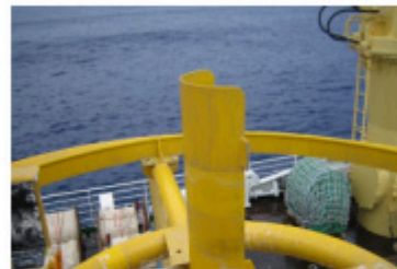
(右) 風向風速計の盗難跡
