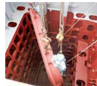
ムーンプールに船上ハッチ(蓋)を取り付ける様子
